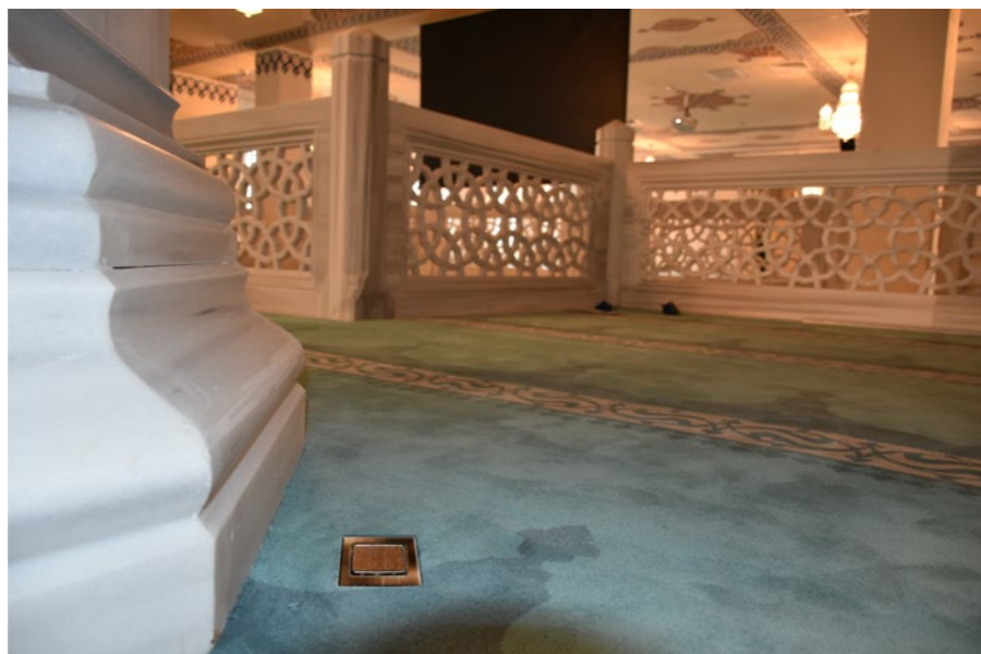
Напольная бронзовая пневморозетка в моельном зале. 2015 год. >
