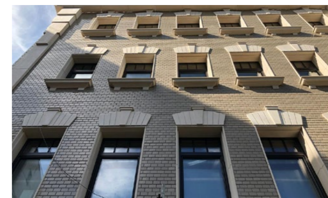
^ Клубный дом в ЦАО. Москва. 2019 год. Коллекторные блоки пылеудаления. 43 блока по 2,0 кВт. 144 пневморозетки.
