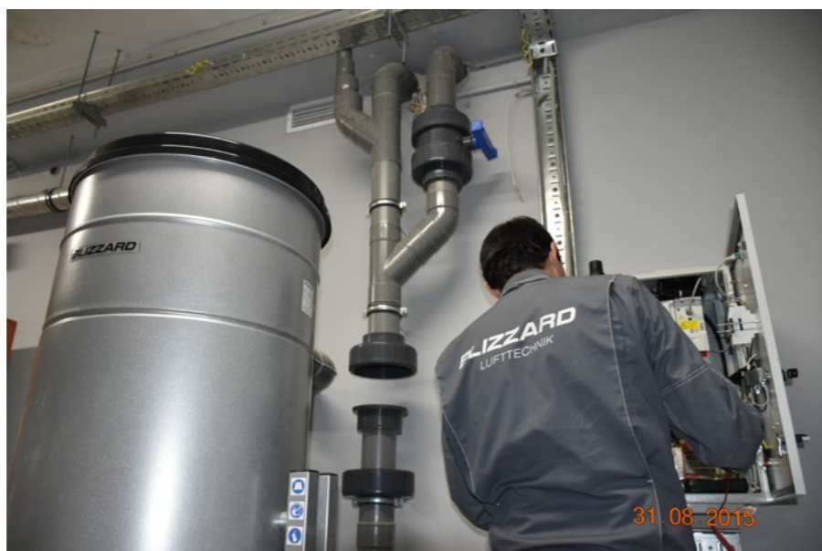
Пусконаладочные работы. 2015 год. >
