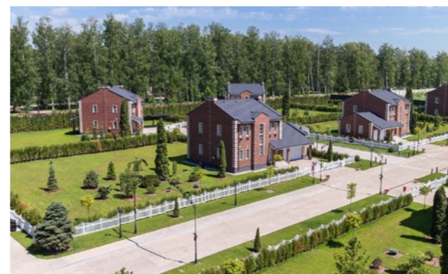
^ Коттеджный поселок «Английский сад». Тульская область. 2015 год. Коллекторные блоки пылеудаления. 12 блоков по 1,8 кВт.
