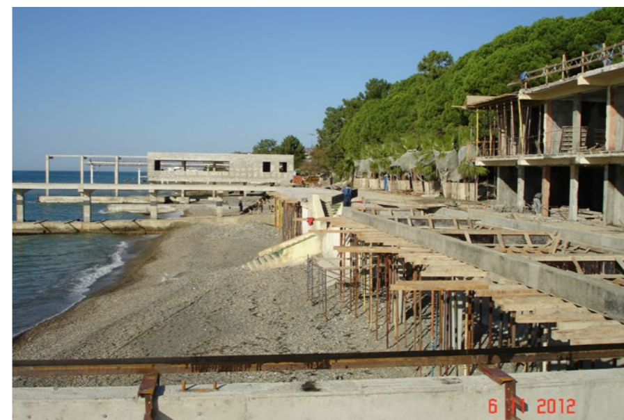
Спальный корпус «Приморский» до реконструкции. 2012 год.
