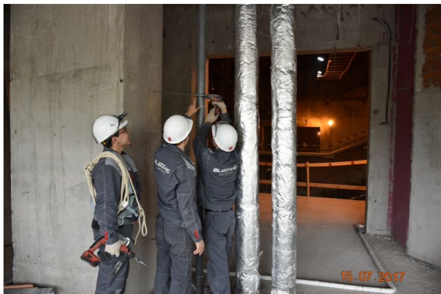
Монтаж вертикальных трубопроводов пылеудаления. 2017 год. >
