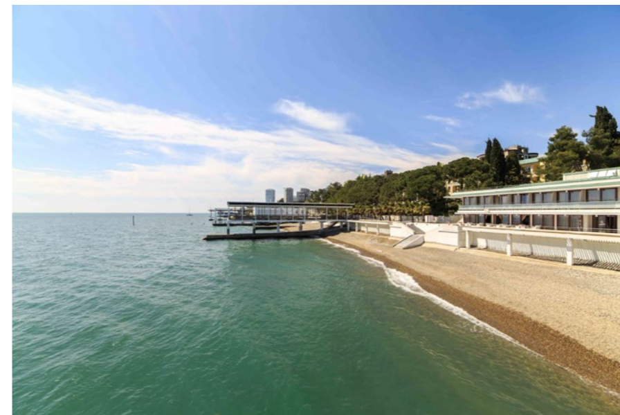
Спальный корпус «Приморский» после реконструкции. 2014 год.
