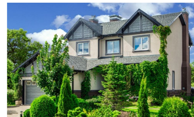
^ Коттеджный поселок «Новые Вешки». Московская область. 2019 год. Коллекторные блоки пылеудаления. 86 блоков по 1,8-2,4 кВт.
