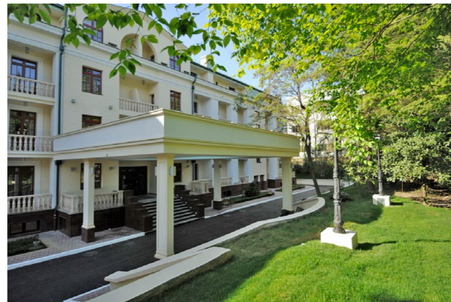
Санаторий «Лесной» ФГБУ «Русь». Сочи. 2011 год. Коллекторные блоки пылеудаления на 5 операторов.
