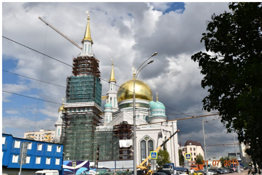
Окончание внешних отделочных работ. 2015 год. >
