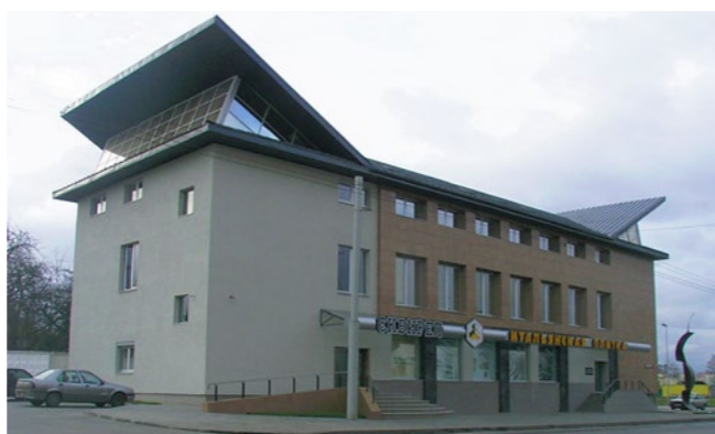
^ Офис «Сквирел-строй». Минск. 2005 год. Коллекторный блок пылеудаления на 1 оператора.
